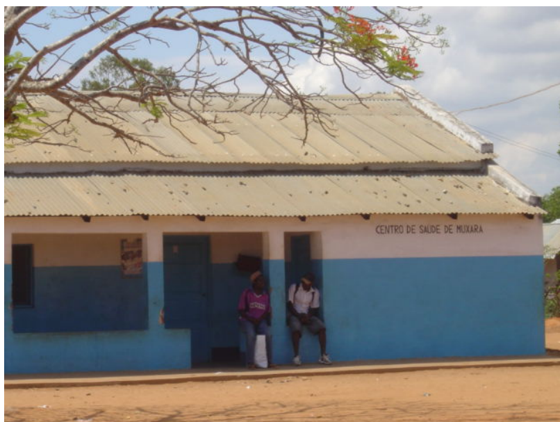
Centro de Saúde nos arredores da cidade—Bairro da Muxara
